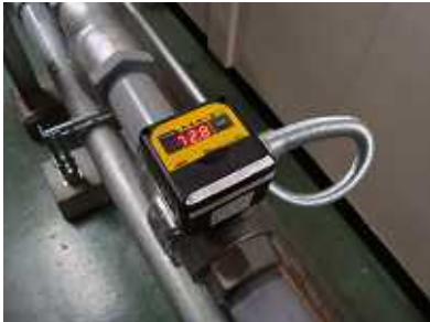
ガスメーターを設置
