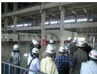
ガスタービン発電機建屋(火力発電所)
